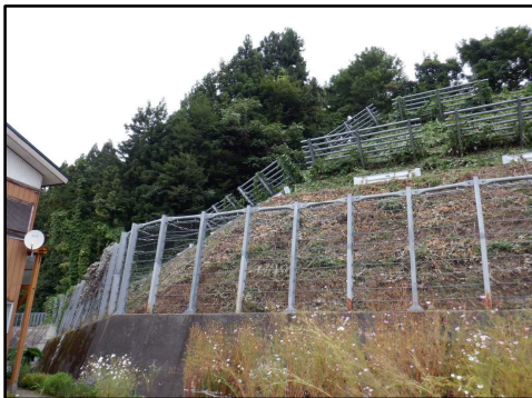
令和2年度 工事施工前
