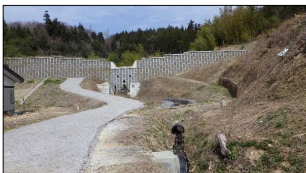
滝ノ沢5 砂防えん堤 R5. 3月時点
