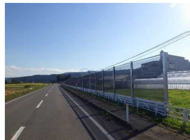
防雪柵 設置状況
