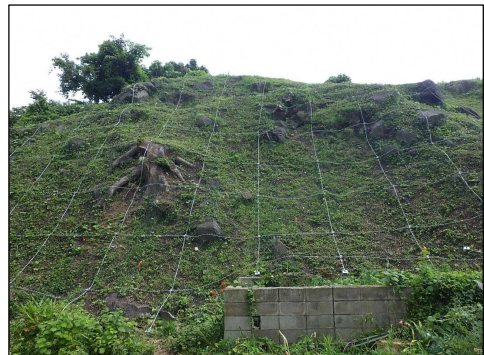
令和2年度 工事完成後（落石予防網工）
