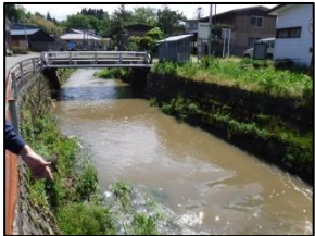
馬踏川(堀内橋)
