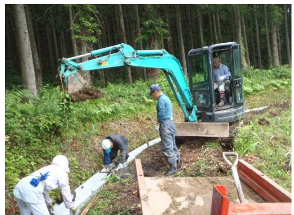
農業用水路の更新
