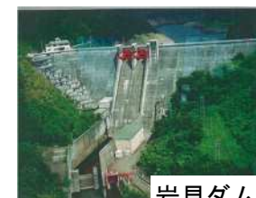
岩見ダム状況写真
